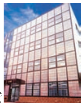
ビル用太陽光発電システム
