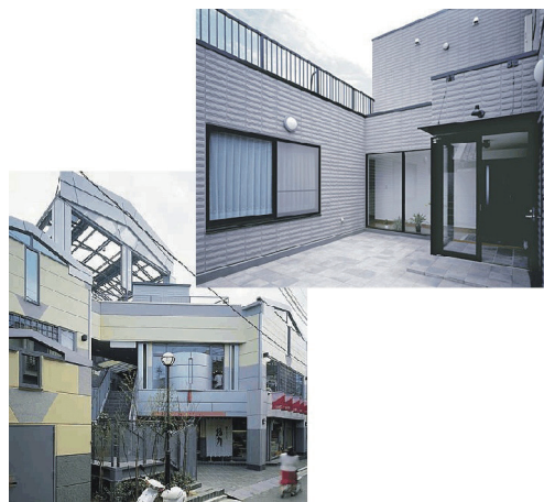
図5 ALCを外壁に使用した施工例
