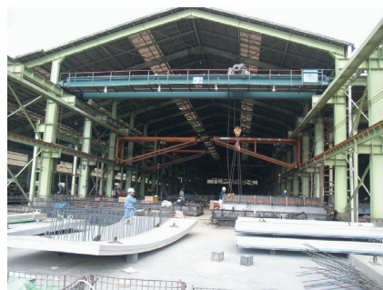
図7 製造棟内の風景
