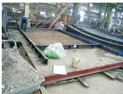
図8 PCa版を製造する鋼製型枠
