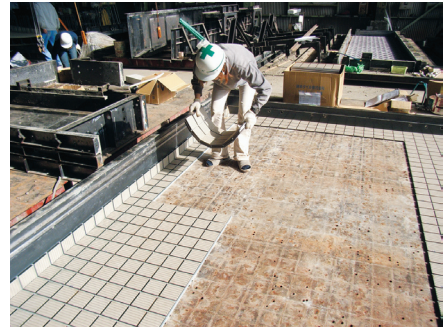
図13 シートパックを型枠へ敷き並べる
