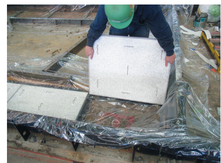
図16 石材を型枠へ敷き並べる
