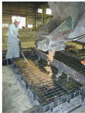
図17 コンクリートの打ち込み
