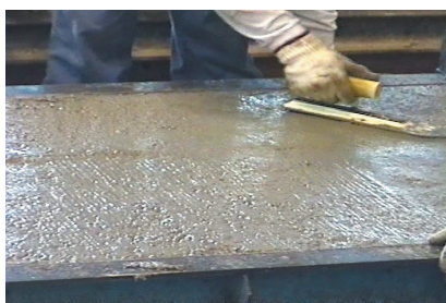
図18 コンクリート表面（PCa 版の裏面） をコテで平滑に仕上げる
