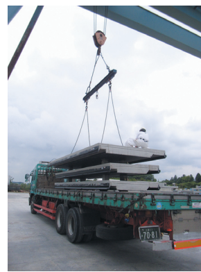
図21 トラックへ積み込み
