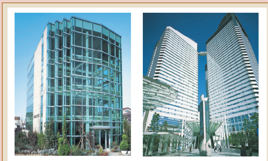
図1 熱線吸収ガラスと熱線反射ガラスの施工例
