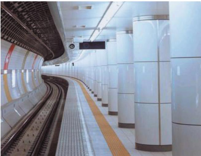
図1 地下鉄駅の建材用結晶化ガラスの円柱群
