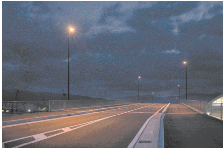
図3 高圧ナトリウムランプを使用した施設例
