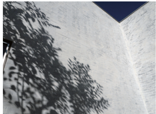
図3 雨のかかり方により、風合いに違いが出始めた外壁
