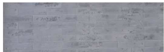
図3 雨のかかり方により、風合いに違いが出始めた外壁
