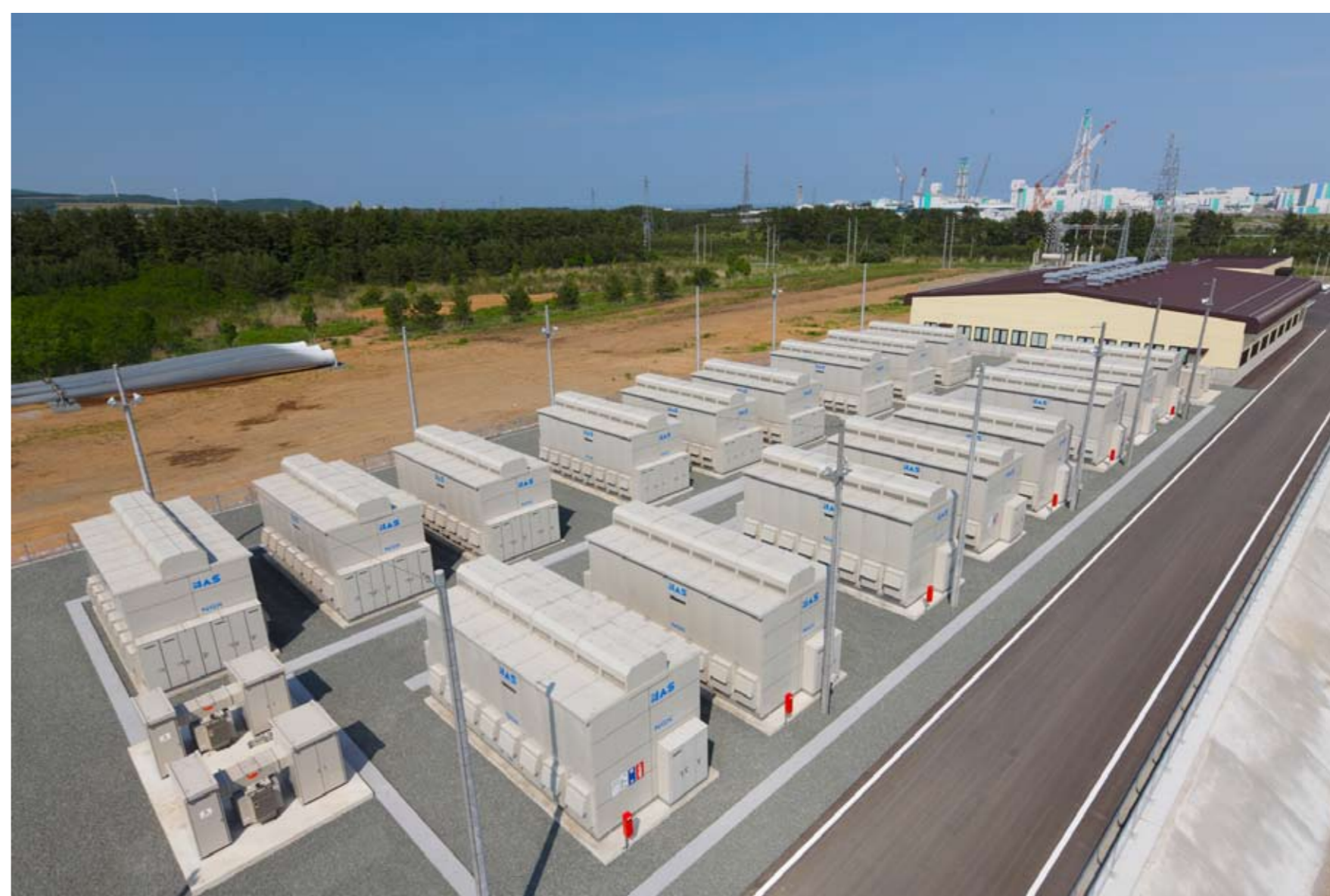
34,000kW NAS電池システム (51,000kW風力発電併設)
