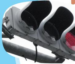
LED(発光ダイオード)の光る部分にはセラミックスが使われているよ。
