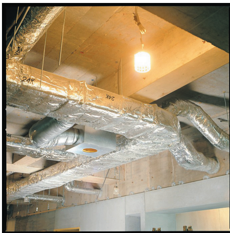
図1 空調用ダクトにアルミ貼りグラスウールを施工した写真
