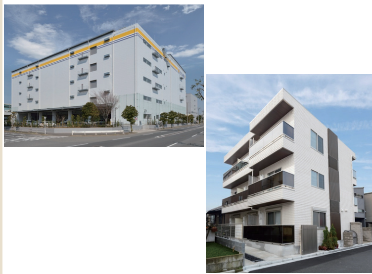
図5 ALC を外壁に使用した施工例
