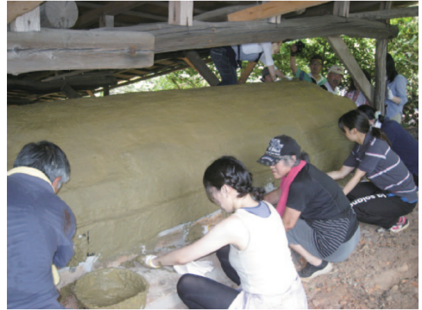
サポーターによる登り窯修理
