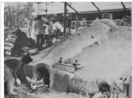
須恵器は窯炉を用いて高火度焼成する、我が国最初の硬質陶器である。5世紀に朝鮮半島の工人によってもたらされたこのやきものは、それ以前の土師器にとって代わり、平安灰釉陶（瓷器）が成立してもなおしばらくは並行しつつ12世紀頃まで焼成された。本稿は番外編として、須恵器の再生に挑んだ記録である。
